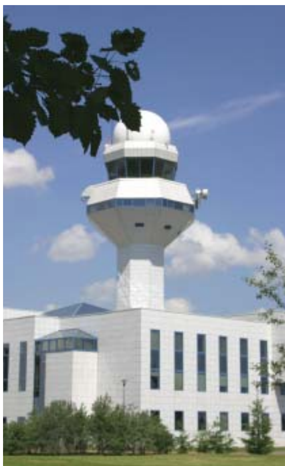
Centrum zarządzania ruchem lotniczym w Warszawie z wieżą kontroli lotniska i radarem obserwacji powierzchni lotniska.
